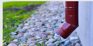
Regenwaterpijp die in tuin wordt geleid
