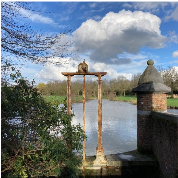
Foto 3: De Oude sluisconstructie
