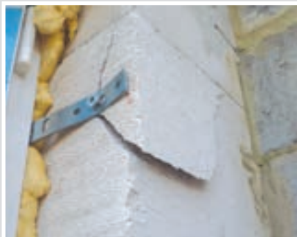
↑ 84 Beschadiging van de binnenmuur door slecht bevestigde bevestigingsbeugel.
