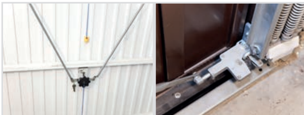
↑ 72 Binnenaanzicht van het mechanisch sluitsysteem aan de binnenzijde van een manueel bedienbare kantelpoort.
