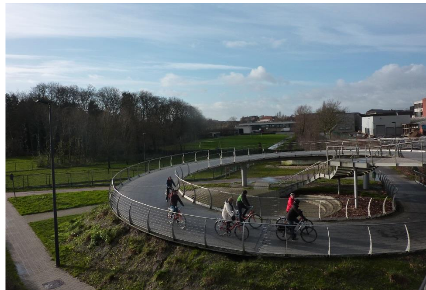
Figuur 26: spiraalvormige fietsbrug in Roeselare
