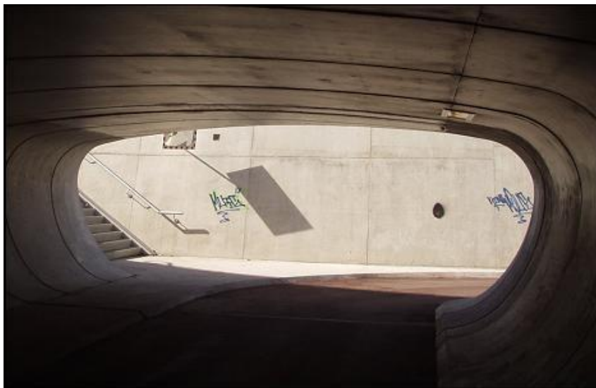
Figuur 25: fietstunnel met trappen
