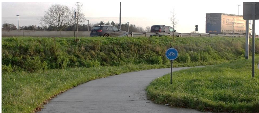
Figuur 9: Fietsweg aangelegd in beton ter hoogte van de Tuinlaan
