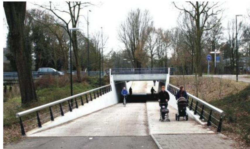
Figuur 21: Voorbeeld van een optisch korte fietstunnel met een goede doorkijk
